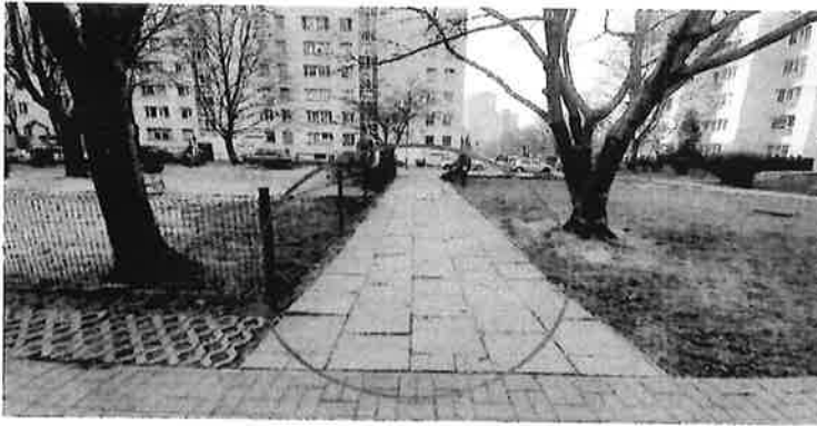
Remont chodnika - wymiana płyt bet. na kostkę brukową przy wejściu na plac zabaw - 50 m 2
