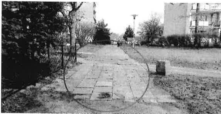
Remont chodnika z wymianą asfaltu na kostkę przed budynkiem do drogi osiedlowej 326 m 2 (obecnie jest 258 m 2 )
