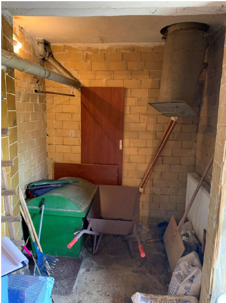
Zdjęcie nr 10 – widoczny fragment ściany wyłożonej płytkami (klatka 1).
