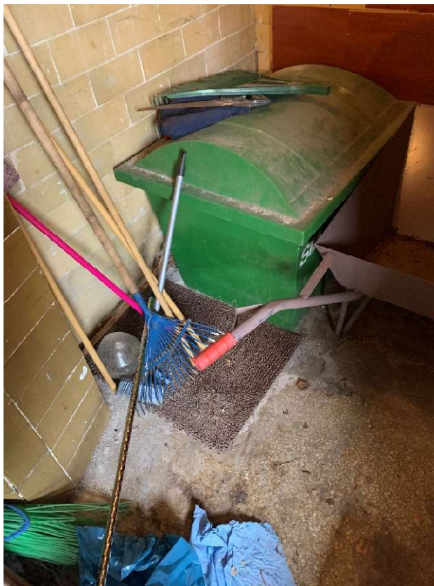
Zdjęcie nr 12 – wykończenie posadzek lastrykiem (pomieszczenia byłego zsypu na śmieci).
