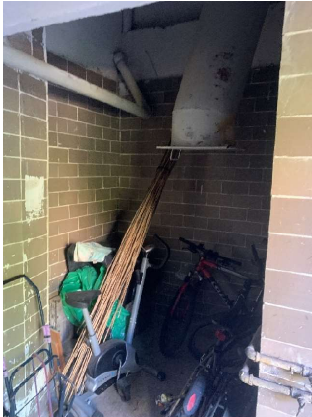
Zdjęcie nr 11 – widoczny fragment ściany wyłożonej płytkami (klatka 3).
