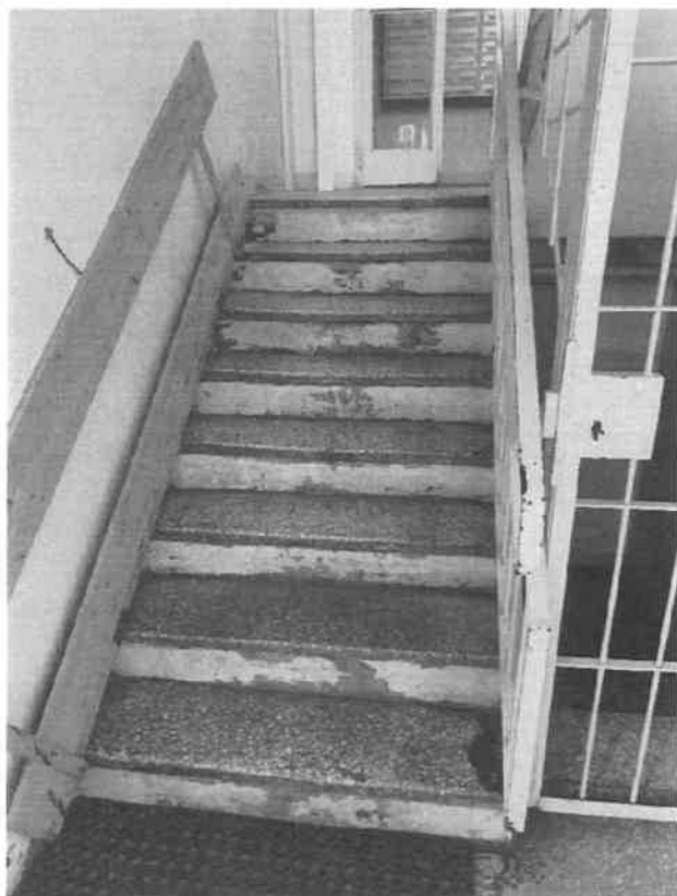
Zdjęcie nr 7 – widoczna strefa wejściowa (prawa strona) na klatkę schodową z oparzeniami i ubytkami lamperii (klatka 2).
